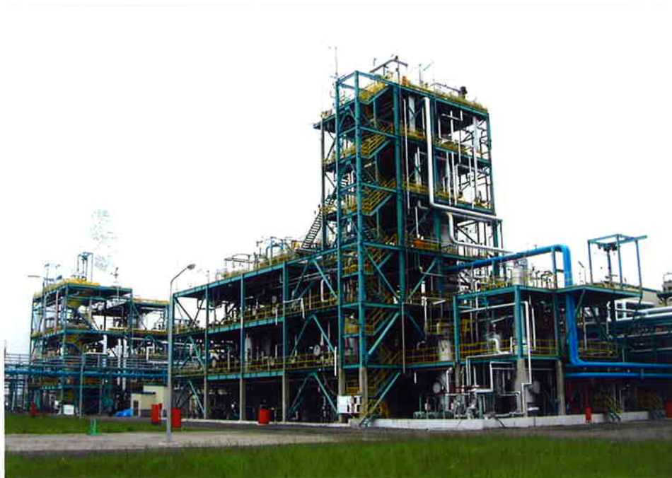
DME100トン/日直接合成実証プラント全景(北海道白糠郡白糠町)
