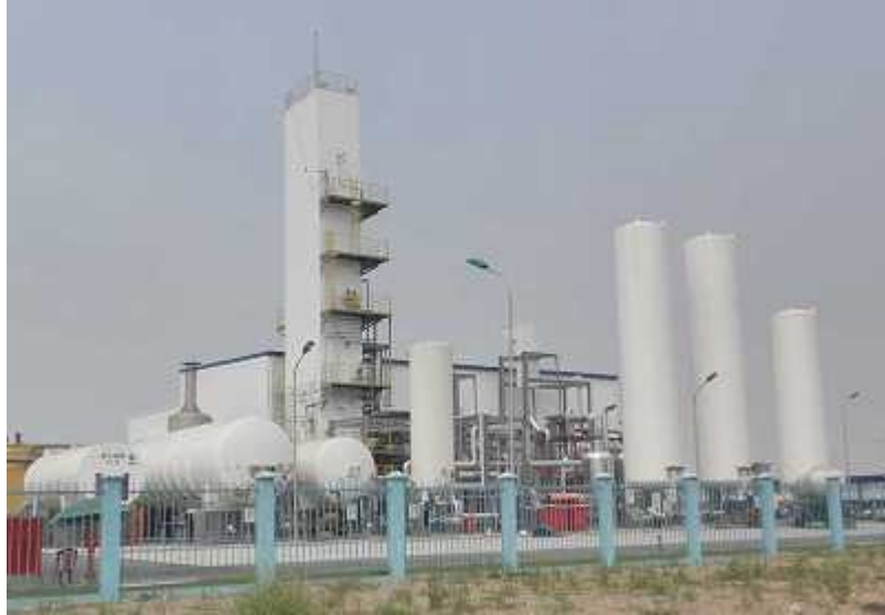
NVJG 新工場全景
