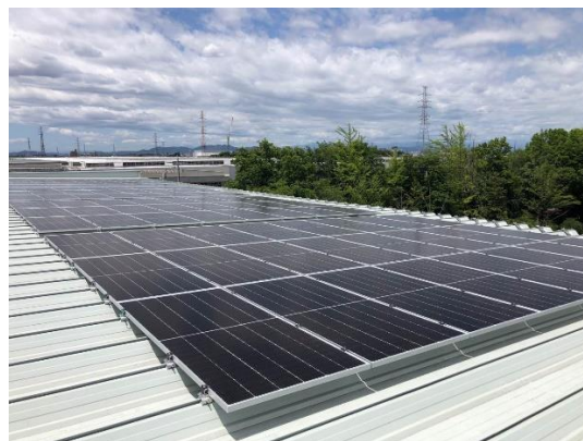
同支店 屋上写真
