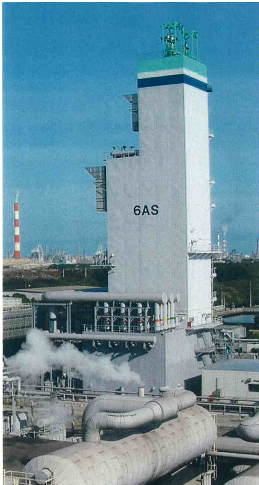
完成した6号空気分離装置
