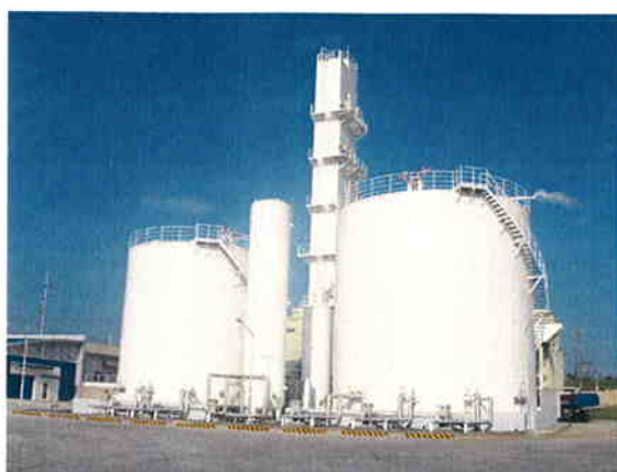
第2号プラント全景
