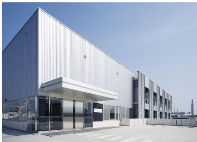
横浜バイオ産業センター 外観
