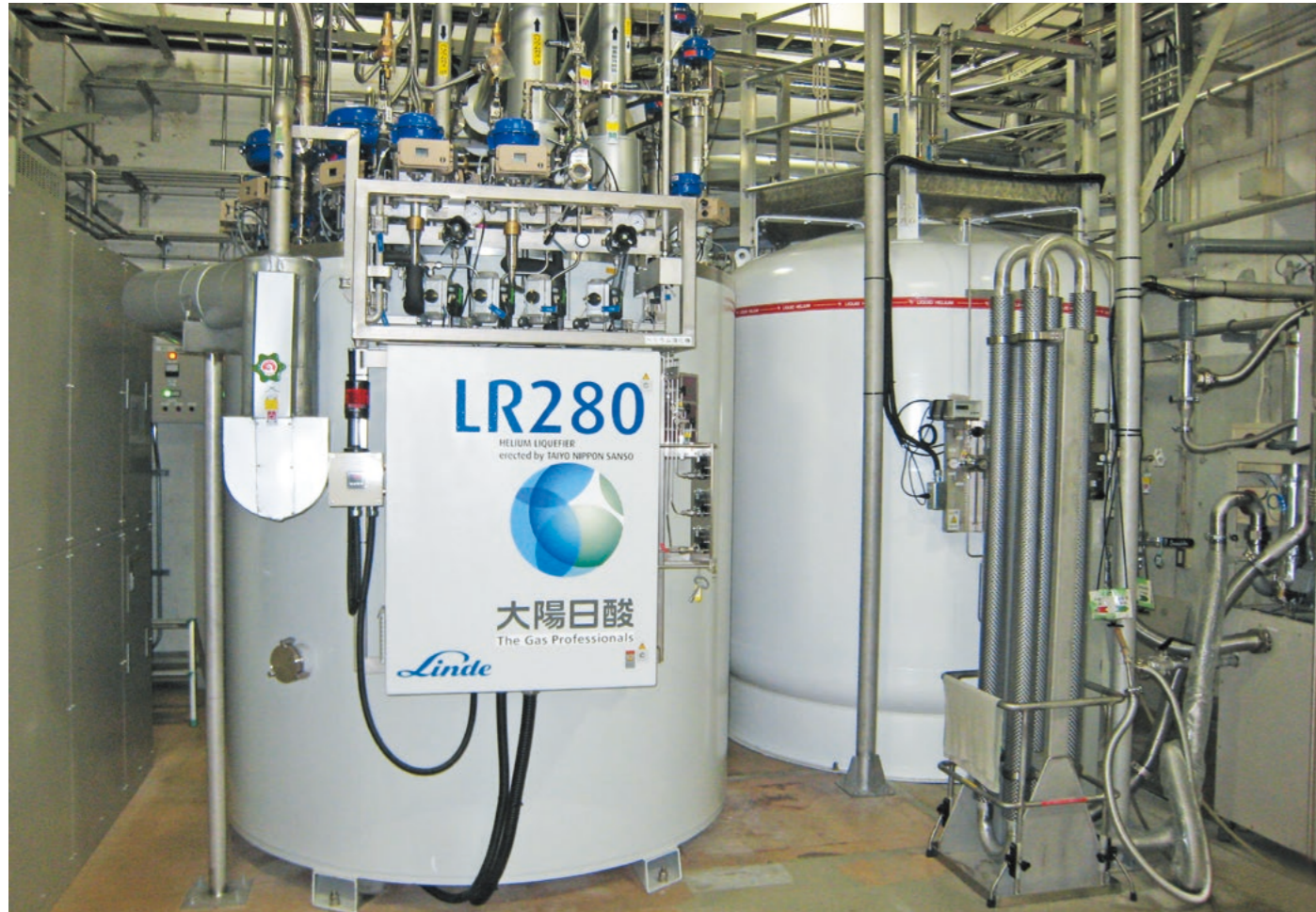
国立大学法人 京都大学 ヘリウム液化機装置(LR280) 液化能力:300L/h以上
